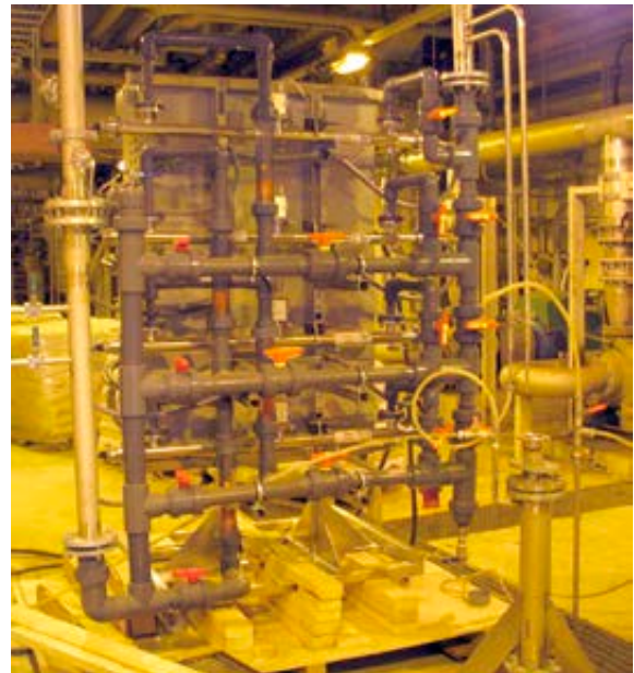
III UV-koelaitteisto orgaanisten epäpuhtauksien hajottamiseksi Stora Enson Oulun tehtaalla. [CEWIC]
