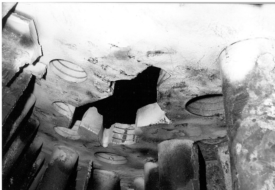
Ett stort stycke av ångdomen fick bytas ut mot ny plåt. Bilden är från haveriet år 1982.
