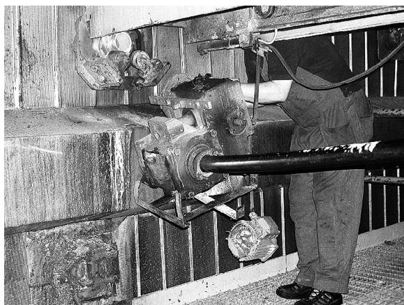
Åkvagnen/växellåds- huset under demon- teringen av blåsaren.
