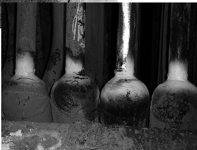
Bild 4: Den skadade tuben vid skada 2/2004
