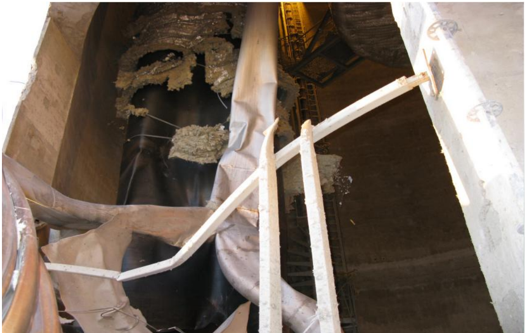
Kuva 13-1. Kuva sisäpiipusta räjähdysen jälkeen
