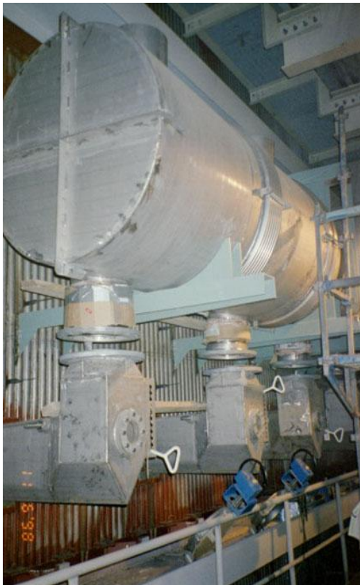
Kuva 5-2. Erään tehtaan laimeiden hajukaasujen polttojärjestelmä asennusvaiheessa.
