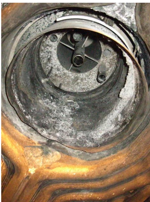
Kuva 7-3. Eräs väkevien hajukaasupoltin kuvattuna kattilan sisältä ja ulkoa.
