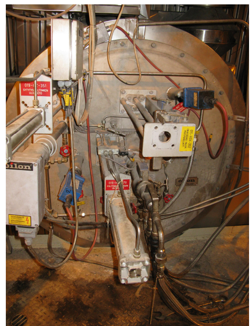
Kuva 7-3. Eräs väkevien hajukaasupoltin kuvattuna kattilan sisältä ja ulkoa.
