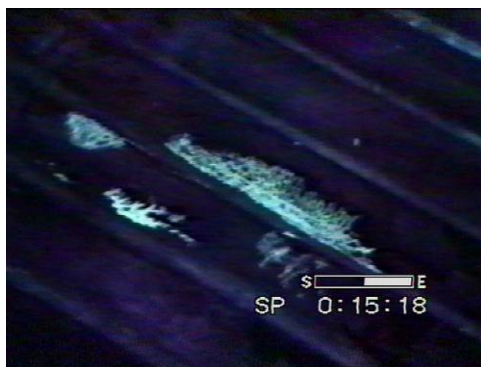
Kuva 3. Fluoresoivalla tunkeumanesteellä tarkastetun pohjan särönäyttämiä
