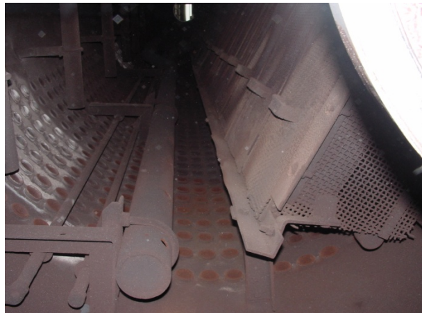
Kuva L 2. Lieriössä epäpuhtauksia ja värimuutoksia
