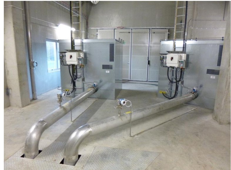
Blåsmaskiner för pneumatisk transport av pulver till lagersilo
