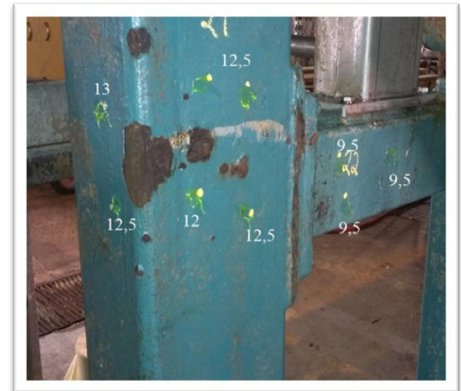
Flagnad färg i kombination med kraftig oxidation
