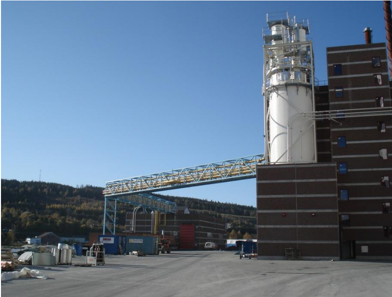
Pulverledning från malning till lagersilo
