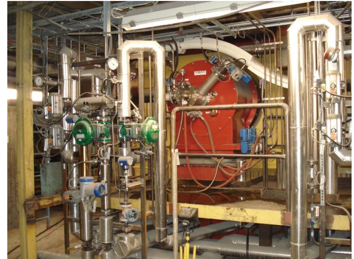
Brännare för träpulver och olja i bark- och kraftvärmepannor
