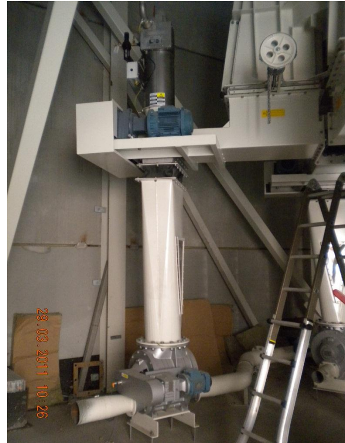
Pulverdoserung från silo till förbränning
