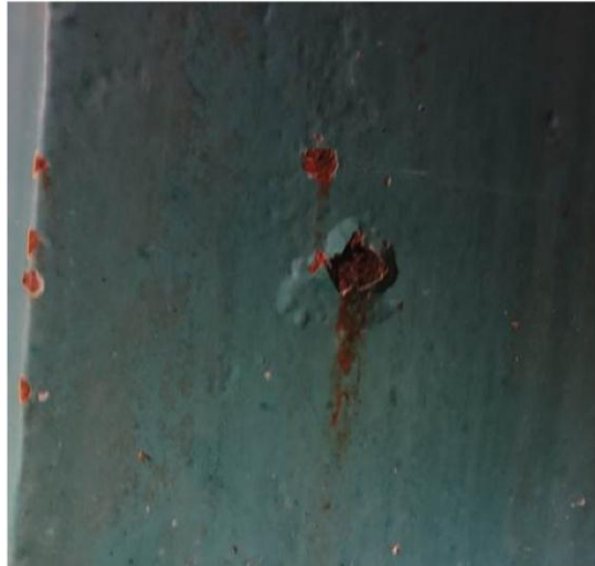
Korrosion startat under färgen
