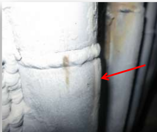
Deformation av gamla delen mot eldstaden.
