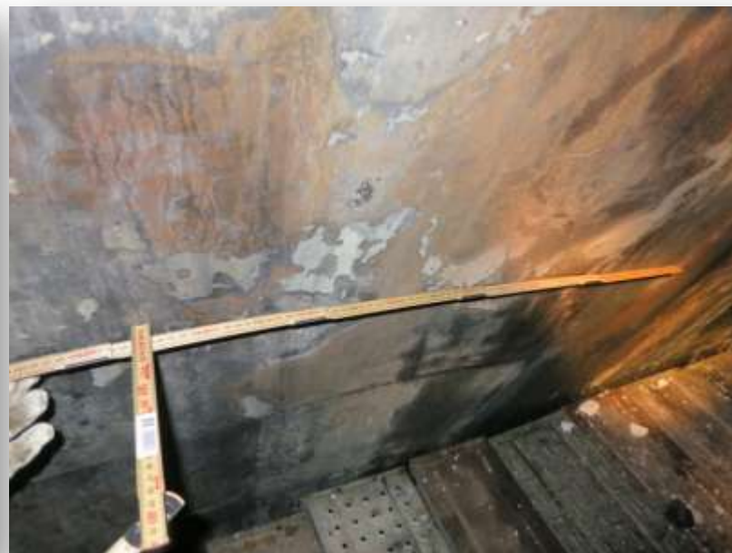
Tanken hade klarat sig mycket bra, endast mindre deformation i övre del
