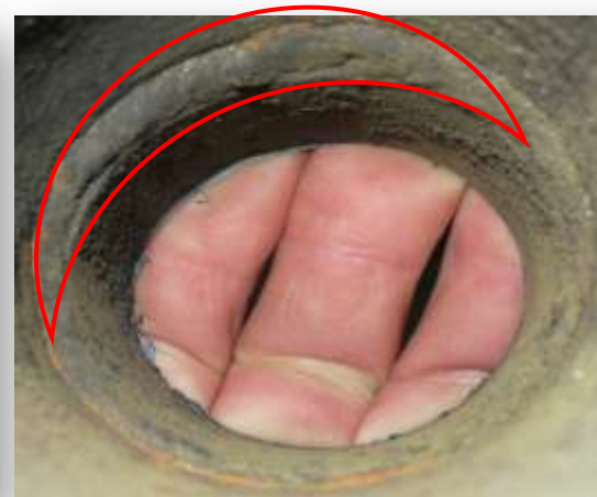
Bindfel på insida tub. Urtagen från eldstads väggen.
