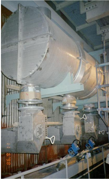
Kuva 5-2. Erään tehtaan laimeiden hajukaasujen polttojärjestelmä asennusvaiheessa.
