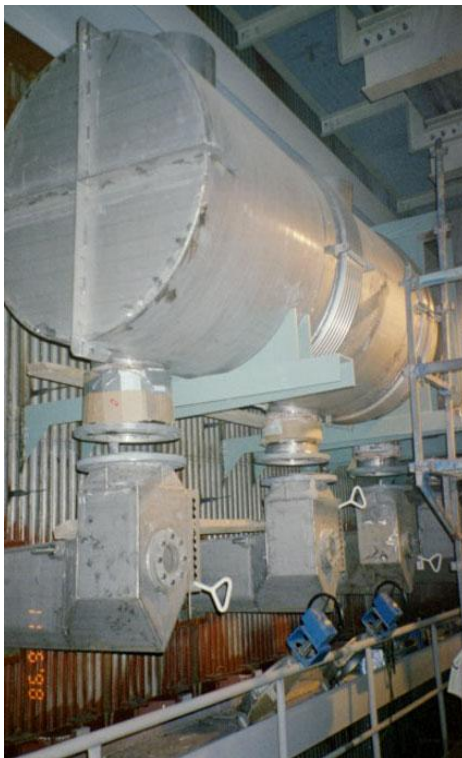
Kuva 5-2. Erään tehtaan laimeiden hajukaasujen polttojärjestelmä asennusvaiheessa.
