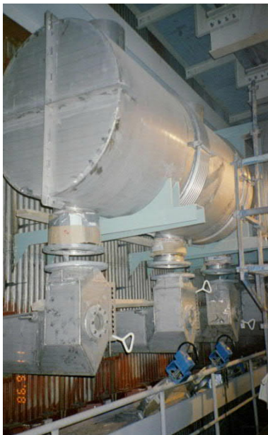
Kuva 5-25-2. Erään tehtaan laimeiden hajukaasujen polttojärjestelmä asennusvaiheessa.
