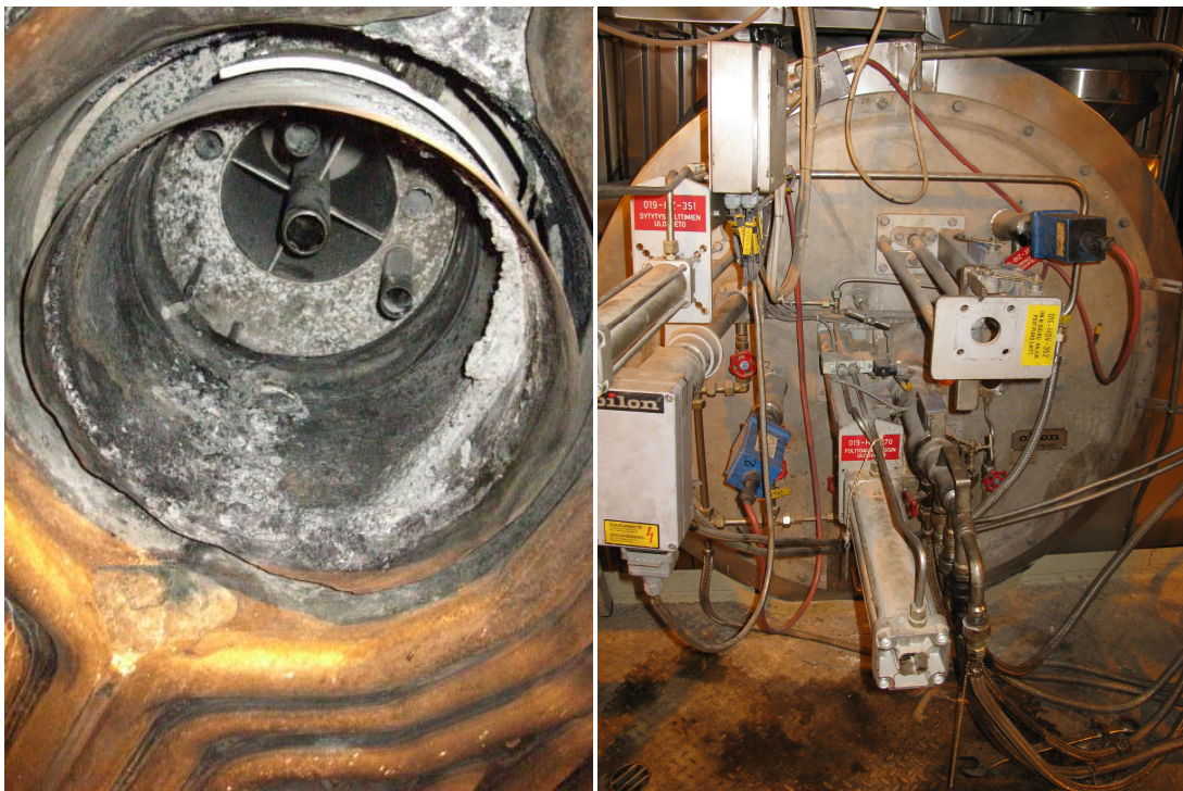
Kuva 7-3. Väkevien hajukaasupoltin kuvattuna kattilan sisältä ja ulkoa.
