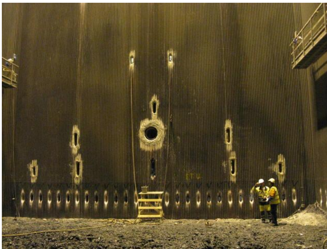
Kuva 7-1. Soodakattilan tulipesän alaosa, jossa keskellä erillispoltin väkeville hajukaasuille.
