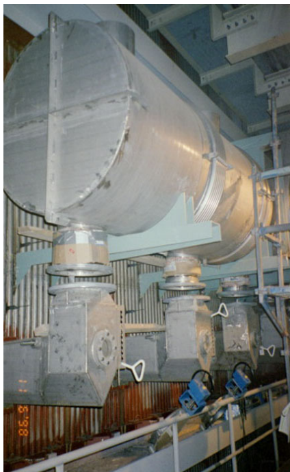
Kuva 5-25-2. Erään tehtaan laimeiden hajukaasujen polttojärjestelmä asennusvaiheessa.
