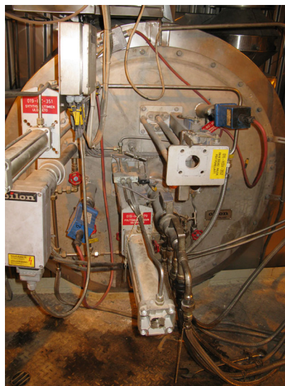
Kuva 7-37-3. Eräs väkevien hajukaasupoltin kuvattuna kattilan sisältä ja ulkoa.
