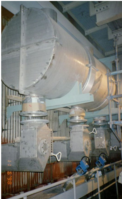
Kuva 5-2. Erään tehtaan laimeiden hajukaasujen polttojärjestelmä asennusvaiheessa.
