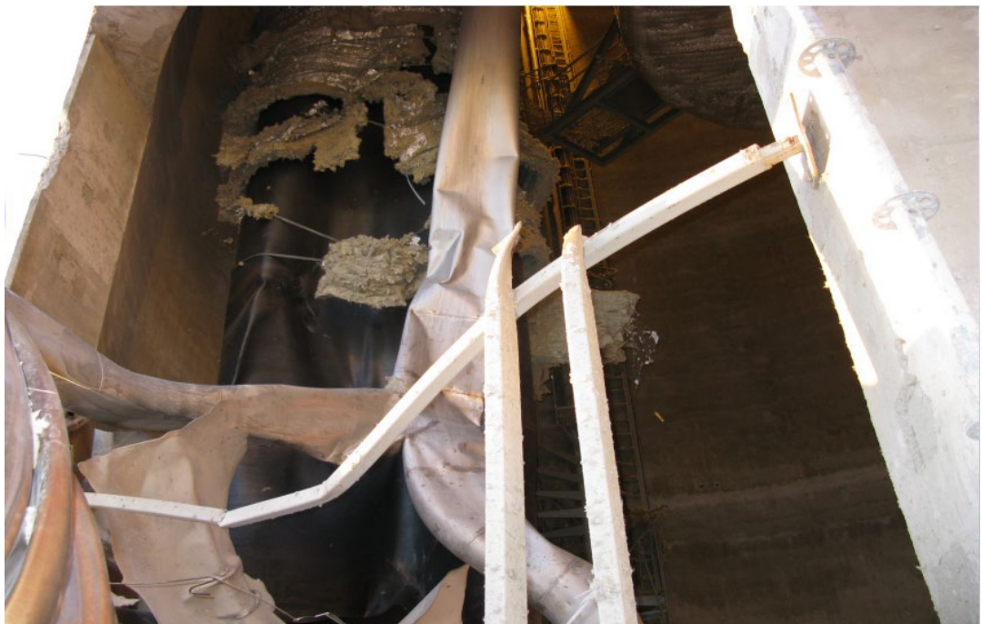
Kuva 13-1. Kuva sisäpiipusta räjähdysen jälkeen
