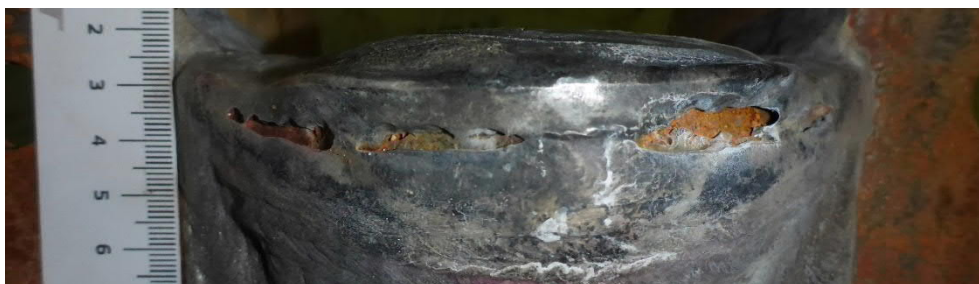
Kuva 76. Oulu 1 jättöpäädyn alapinta. Pinnoite syöpynyt puhki paljastaen perusaineen.
