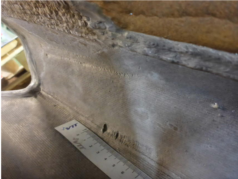
Kuva 5. Rassauksen jättämiä jälkiä sulakourussa Enocell1
