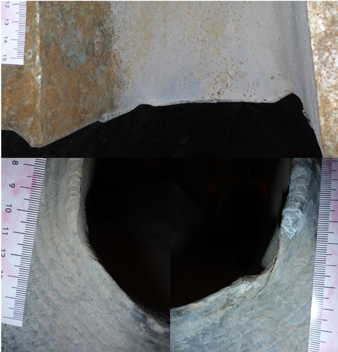
Kuva 137. Sulakourun Rauma 6 jättöpääty
