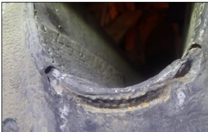
Kuva 7-1. Esimerkki rännin kärjen (tippanokka) syöpymisestä
