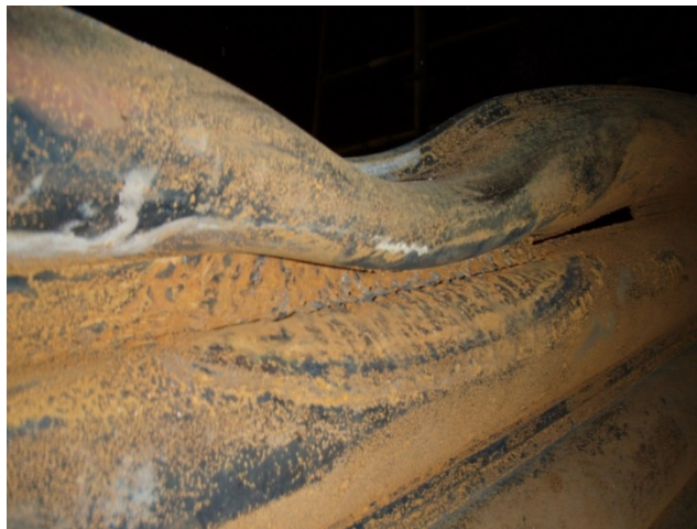
Kuva 15. Verhoputkivuoto MF Rauman soodakattilassa 2011
