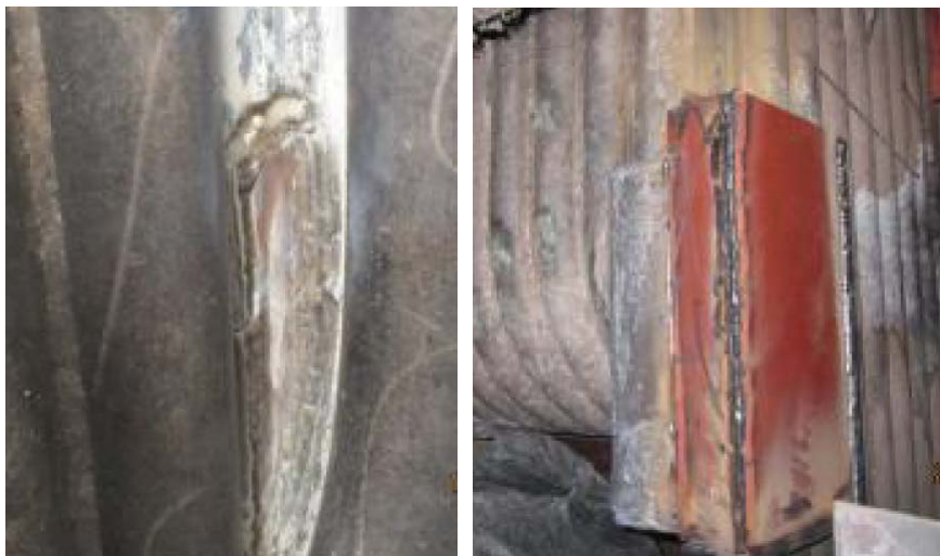
Uusi kattila - hätäkorjaus
