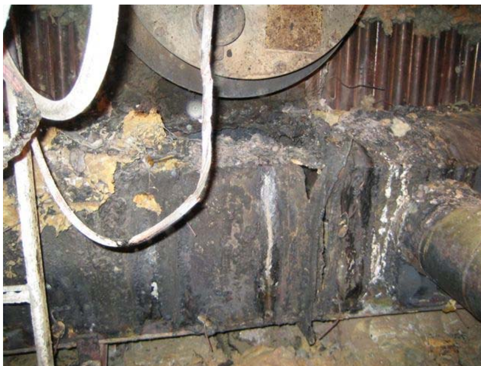
Kuva 3: Vaurioitunut hajukaasukanava.
