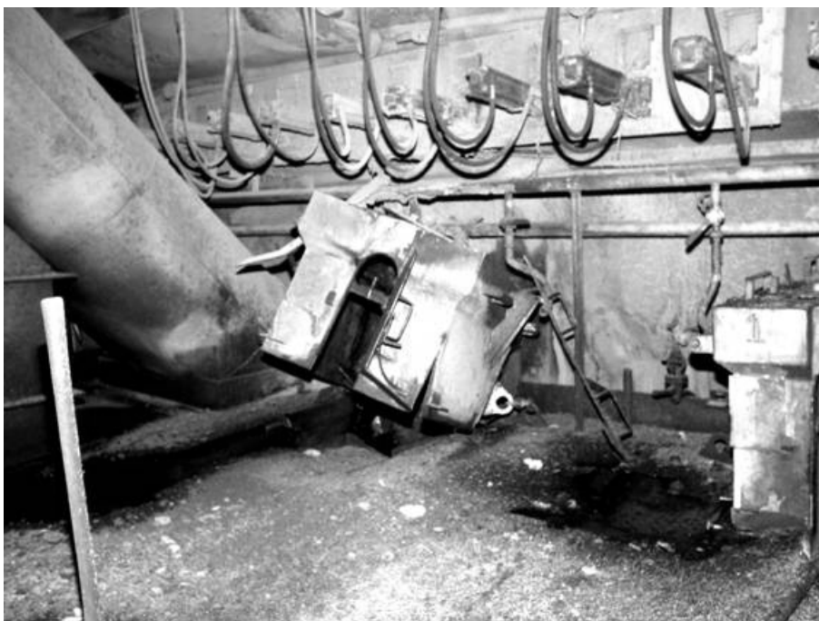
Kuva 7. Irronnut sularännin suojakotelo
