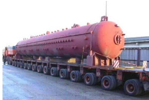
20 m pitkä lieriö matkalla asennustyömaalle
