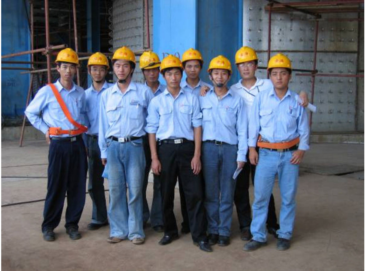
Kuva 8. Operaattoreita tutustumassa rakenteilla olevaan soodakattilaan kesäkuussa 2004
