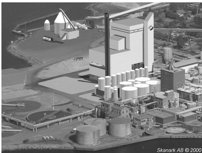
Kuva 3. Ruotsin uusiin soodakattila, Skoghall, käynnistetään 22. lokakuuta. (Kuva Akerkvaerner Oyj:n luvalla.)
