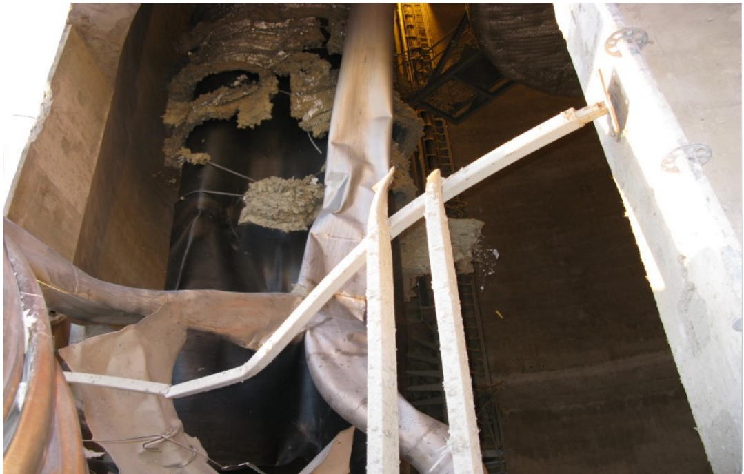
Kuva 15-1. Kuva sisäpiipusta räjähdysen jälkeen
