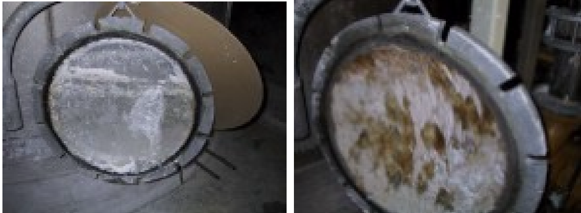
Kuvat 3.4 ja 3.5. Sähköllä käsitelty säiliö (vas.) ja säiliö normaalissa tilassa (oik.).
