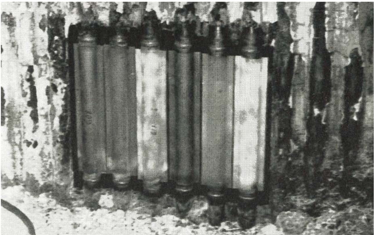
Kuva. Kuusi_Cormet Oyn päällystämää evällistä tuubia asennettuna Kaukopään kattilan oikean seinän alaosaan primääri-ilma-aukkojen alapuolelle
