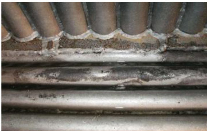
Kuva L4. Korjauskohta pohja-seinä-kamparaudassa
