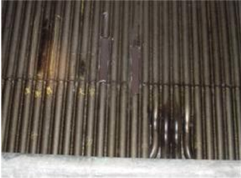
Kuva L1. Värimuutoksia seinällä
