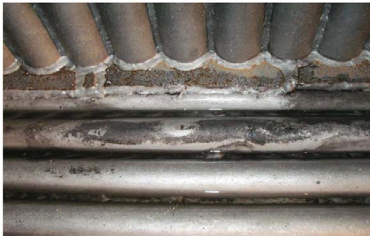
Kuva L 4. Korjauskohta pohja-seinä-kamparaudassa
