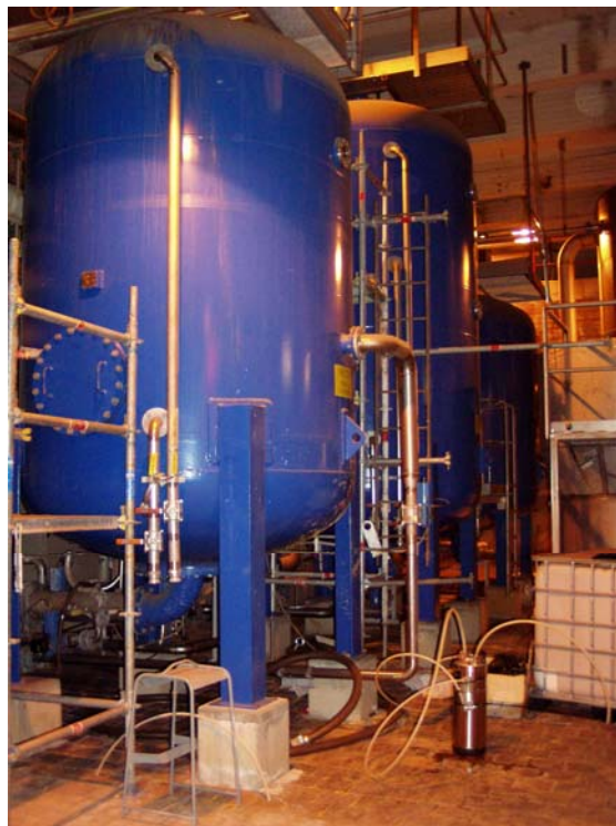
Kuva 37. Mini-Cyclesorb MS20-suodatin (oikealla alhaalla) suolanpoistosarjassa. Siniset säiliöt edestä taaksepäin ovat: sekavaihdin, anioninvaihdin ja kationinvaihdin.
