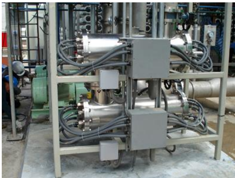
Kuva 50. UV-käsittelylaitos kattilavedelle (47)
