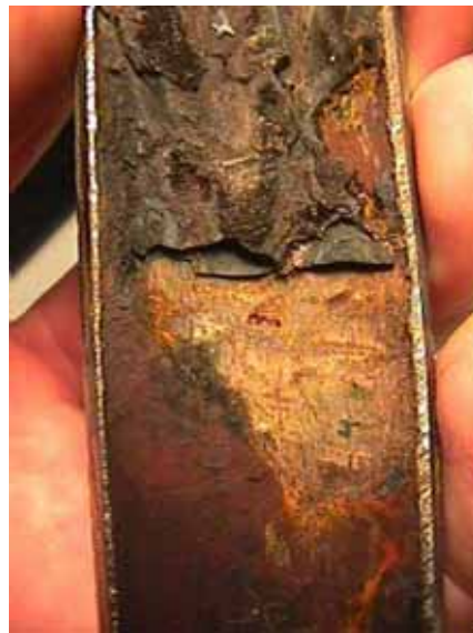
Korrodoituneen seinäputken sisäpinta
