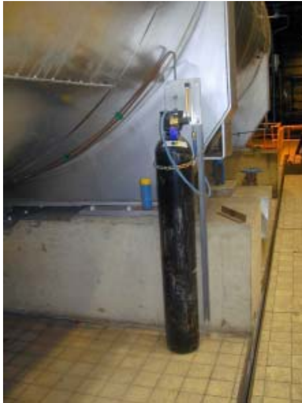
Kuva 11. Hapen annostelulaitteisto (syöttö syvesäiliön jälkeen).
