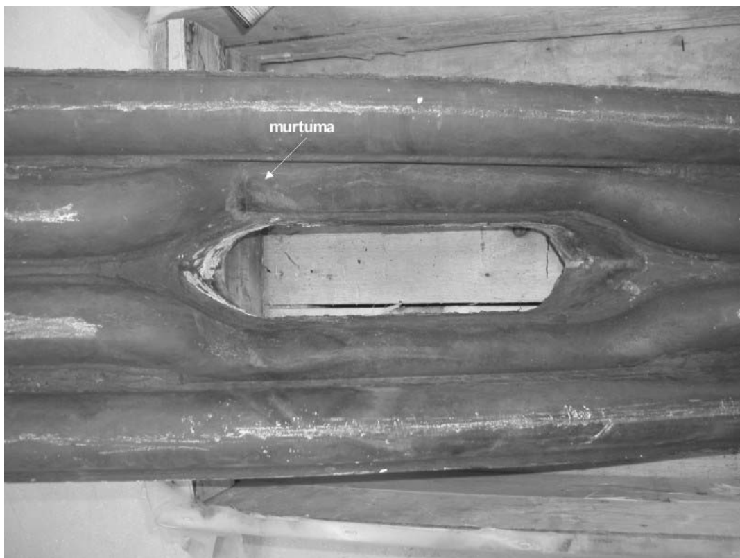
Kuva 3: Tutkittavaksi toimitettu putkirakenne.
