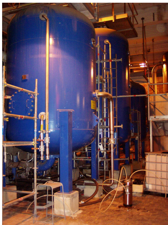
Kuva 38. Mini-Cyclesorb MS20-suodatin (oikealla alhaalla) suolanpoistosarjassa. Siniset säiliöt edestä taaksepäin ovat: sekavaihdin, anioninvaihdin ja kationinvaihdin.
