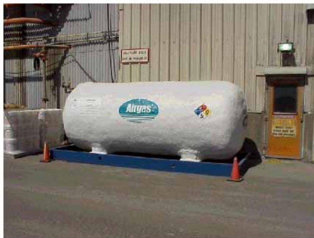
Kuva 37. Nestemäisen \text{CO}_2 :n säilytystankki [30].
