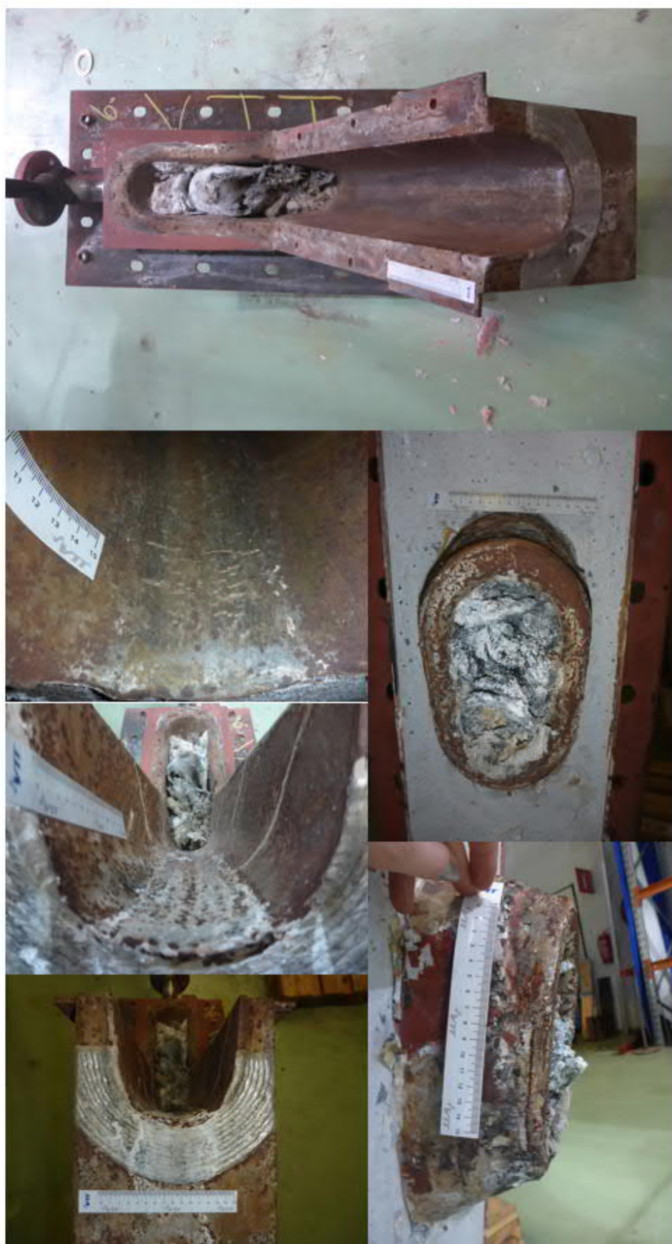
Kuva 105. Tutkimuksiin toimitettu ränni (Äänekoski 6)
