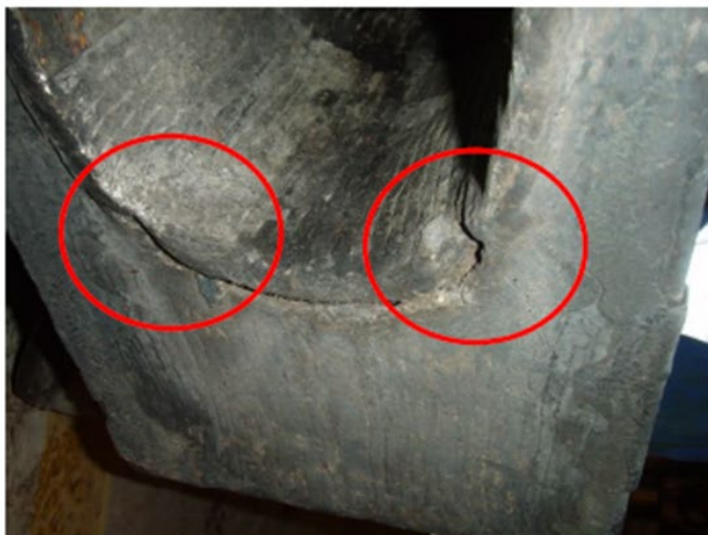
Kuva 7-1. Esimerkki rännin kärjen (tippanokka) syöpymisestä
