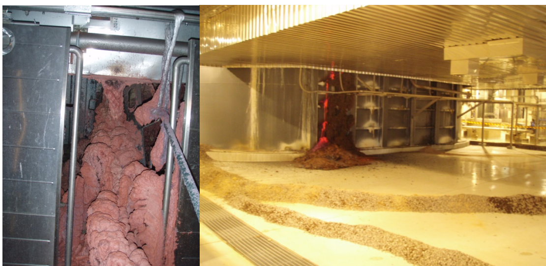
Kuva 6-1. Esimerkkejä sulavuodosta kattilan ulkopuolelle
