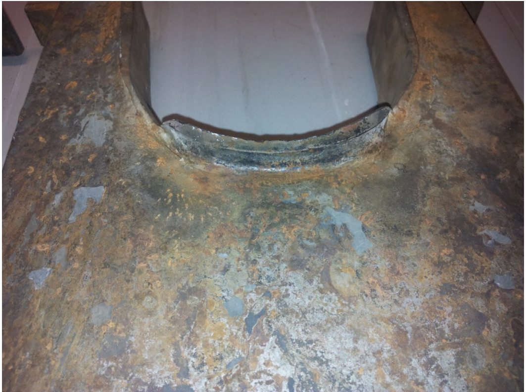
Kuva 6-2. Vuoden kattilassa ollut pinnoittamaton ränni
