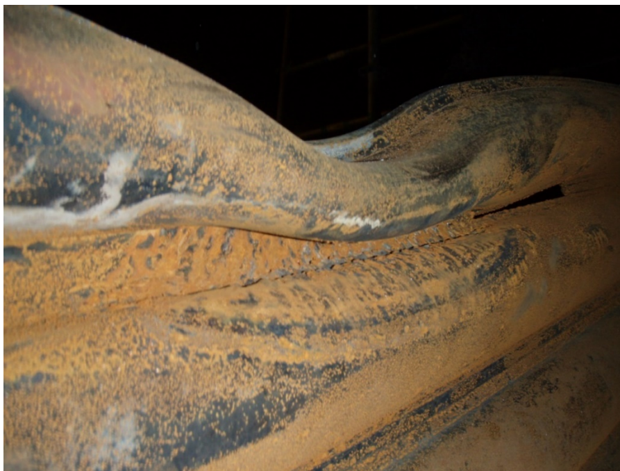
Kuva 15. Verhoputkivuoto MF Rauman soodakattilassa 2011
