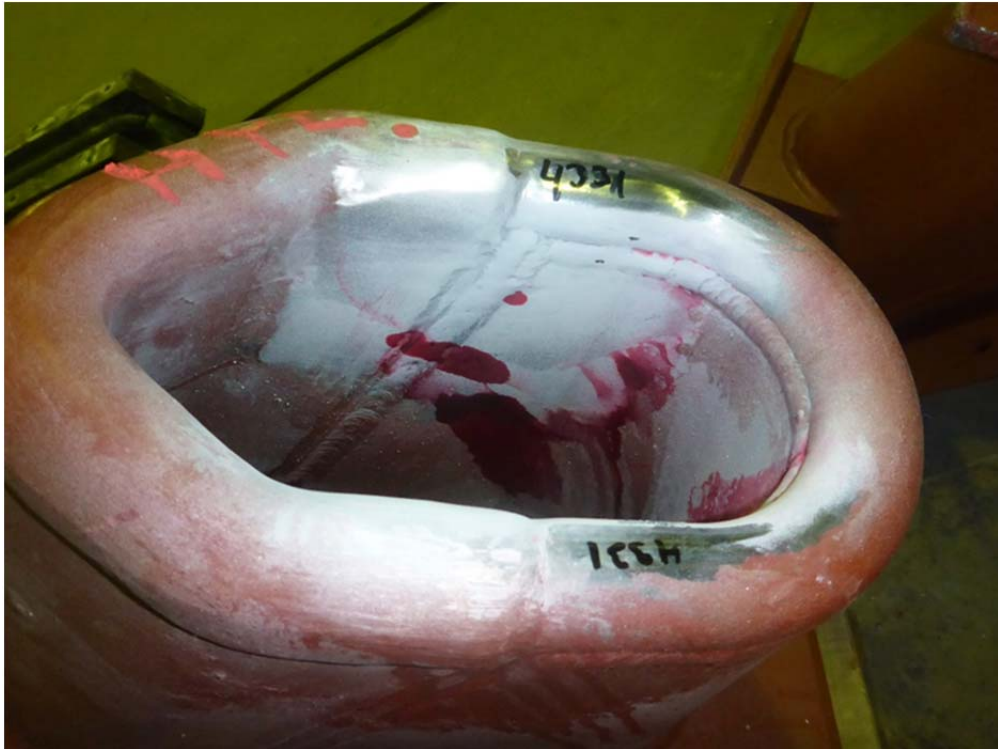
Kuva 6-4. Esimerkki pintatarkastuksessa havaituista vioista.
