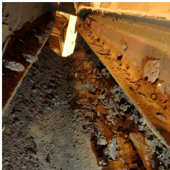
Figur 7 Beläggningar inuti löpränna efter drift på Panna I som har mekaniskt renat kylvatten.
