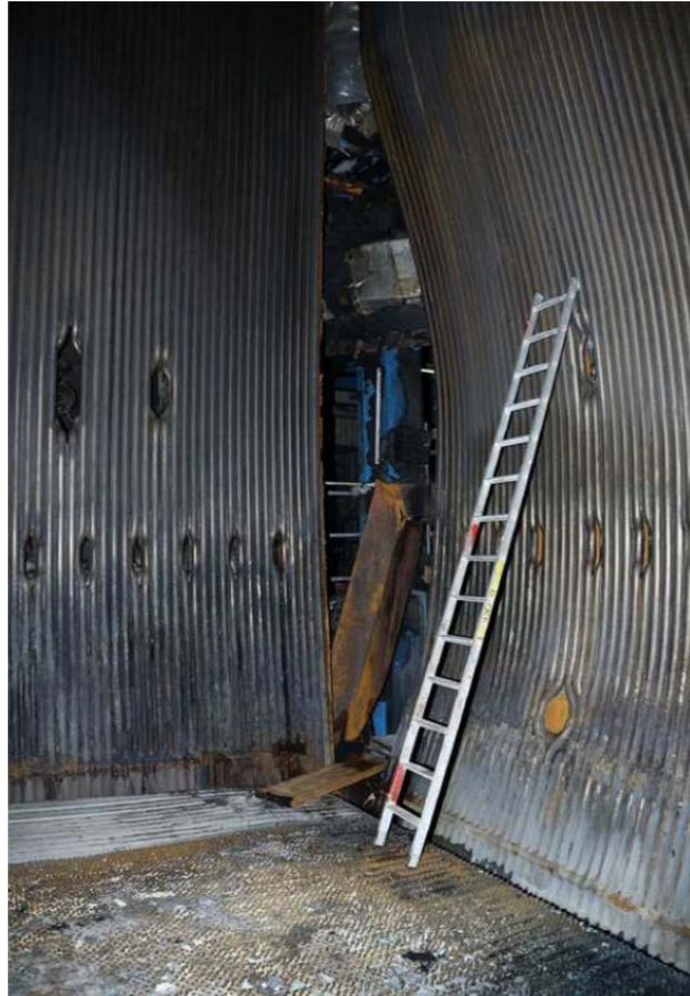
Kuva 3. Zellstoff Pölsin soodakattila räjähdysen jälkeen
