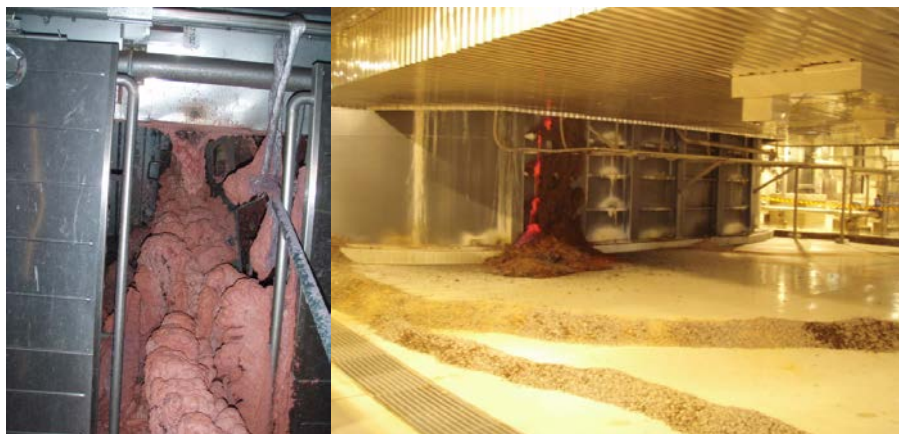
Kuva 2-1. Esimerkkejä sulavuodosta kattilan ulkopuolelle
