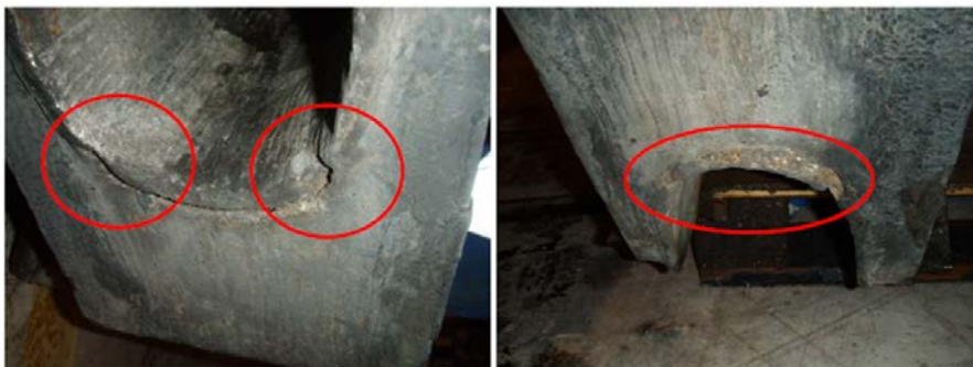
Kuva 3-1. Esimerkki jättöreunan syöpmisestä
