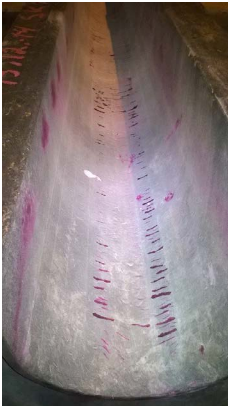
Kuva 4-2. Tunkeumanestetarkastuksessa havaittuja säröjä
