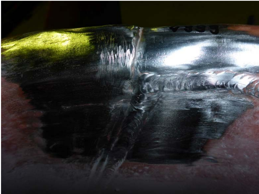
Kuva 5-9. Esimerkki valmistuksenaikaisista hitsausvirheistä, mm. jyrkät liittymät näkyvät selvästi
