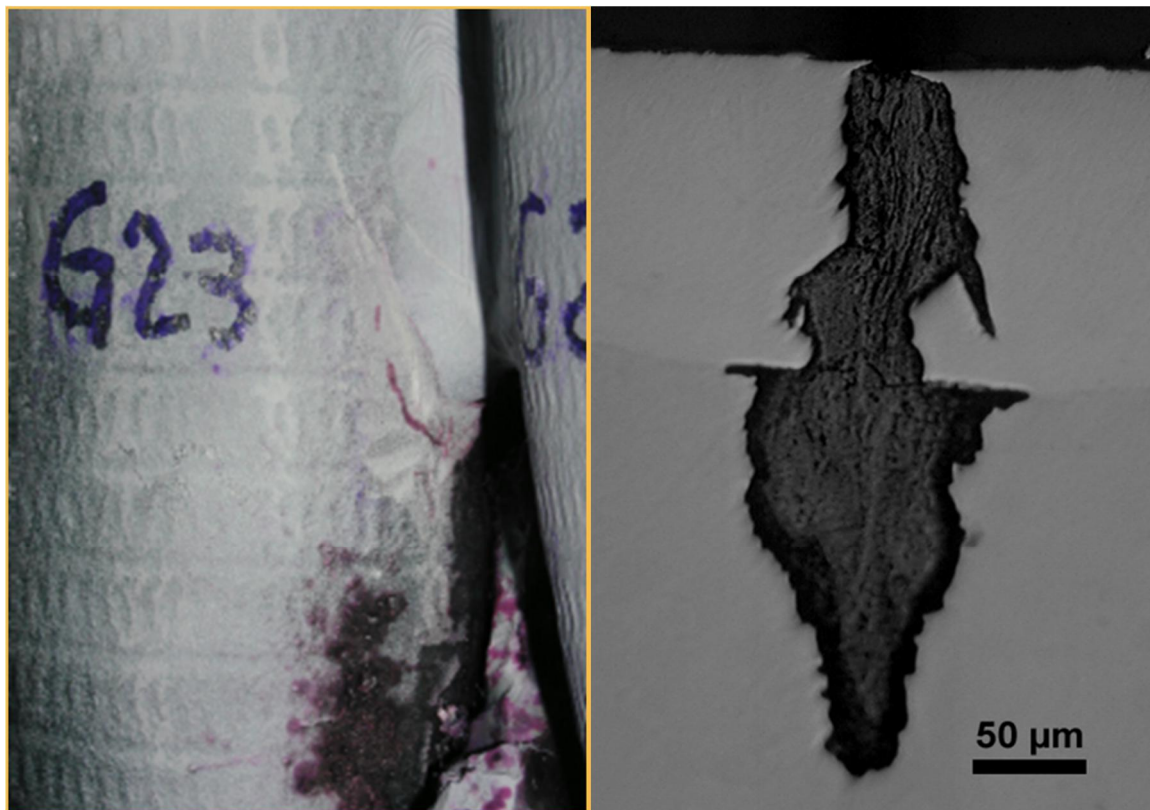
Kuva 14. Alloy 625 hitsauspinnoitteen murtumia primääri-ilma-aukon ohitusputkessa. Osa säröistä on edennyt hiiliteräksen puolelle. [28]
