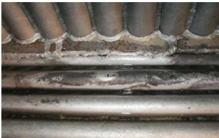
Kuva L4. Korjauskohta pohja-seinä-kamparaudassa
