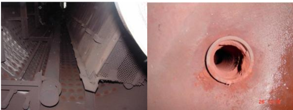
Kuva L2. Lieriössä epäpuhtauksia ja värimuutoksia
