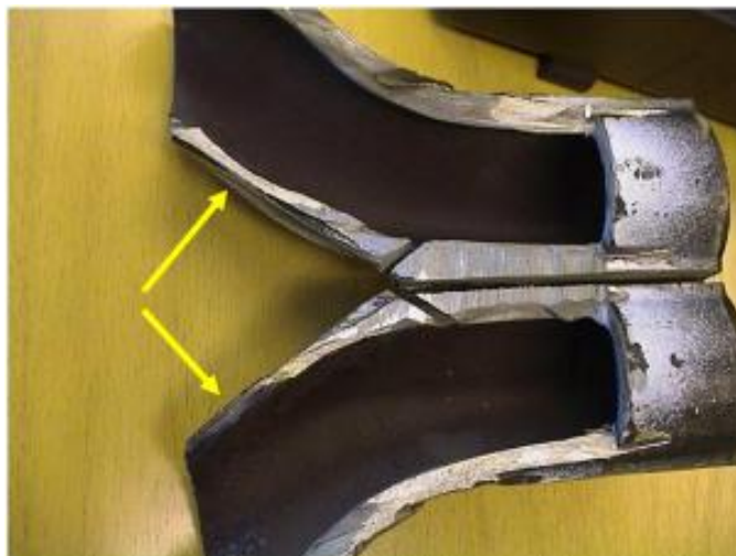
Kuva L3. Korroosioaurio ilma-aukon ohitusputkissa. Vikakohdat merkitty nuolilla
