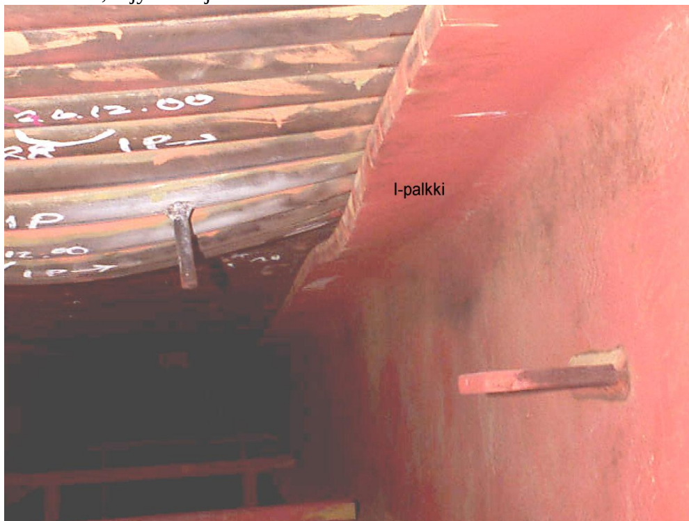
Kuva 5-2. Taipuneet pohjaputket ja kannatuspalkki
