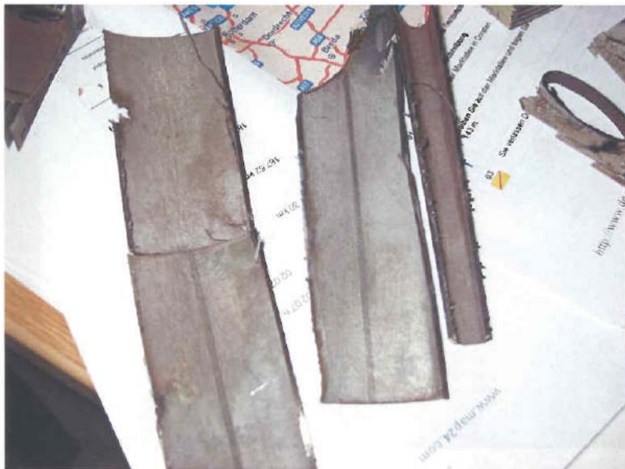
Kuva 5. Kuva puhdistetun putkinäytteen sisäpinnasta, jossa hitsausauma oli kulunut eroosion vaikutuksesta lähes kokonaan.
