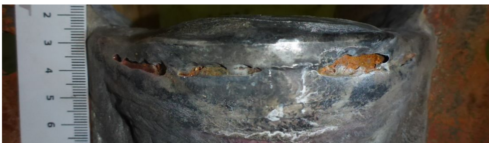
Kuva 72. Oulu 1 jättöpäädyn alapinta
