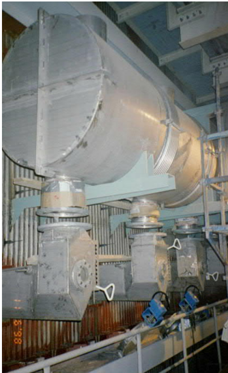
Kuva 5-2. Erään tehtaan laimeiden hajukaasujen polttojärjestelmä asennusvaiheessa.
