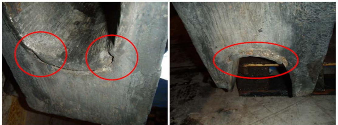
Kuva 3-1. Esimerkki jättöreunan syöpmisestä
