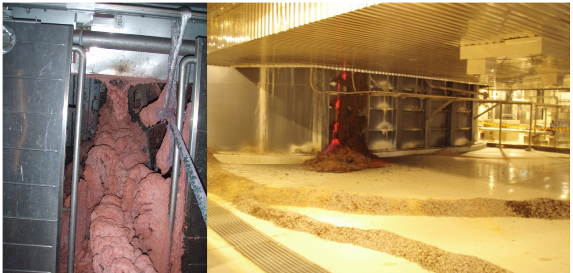
Kuva 2-1. Esimerkkejä sulavuodosta kattilan ulkopuolelle
