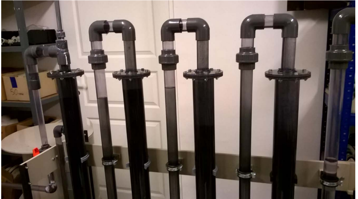
Kuva 6. Tilanne sakkalietteen syötön jälkeen.
