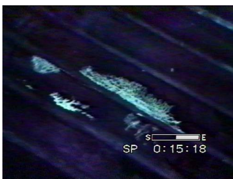
Kuva 4-4. Fluoresoivalla tunkeumanesteellä tarkastetun pohjan särönäyttämiä
