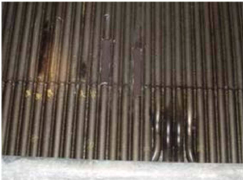
Kuva L1. Värimuutoksia seinällä
