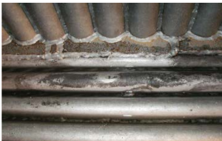
Kuva L4. Korjauskohta pohja-seinä-kamparaudassa
