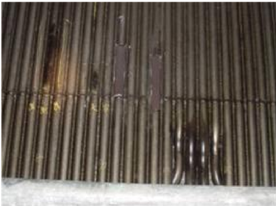
Kuva L1. Värimuutoksia seinällä
