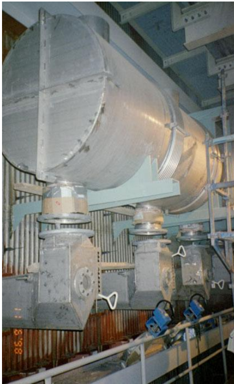
Kuva 5-2. Erään tehtaan laimeiden hajukaasujen polttojärjestelmä asennusvaiheessa.
