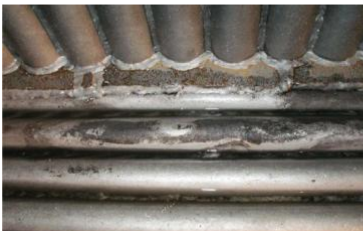
Kuva L4. Korjauskohta pohja-seinä-kamparaudassa
