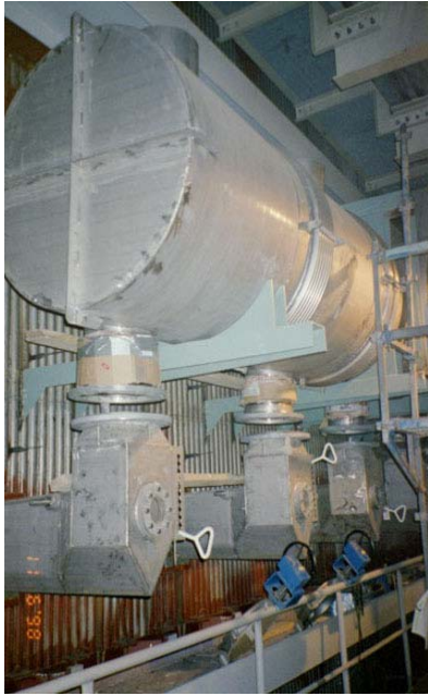
Kuva 5-2. Erään tehtaan laimeiden hajukaasujen suuttimet
